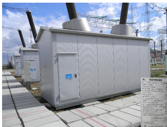
Рисунок 2- Силовой выключатель 3AT2 DT
