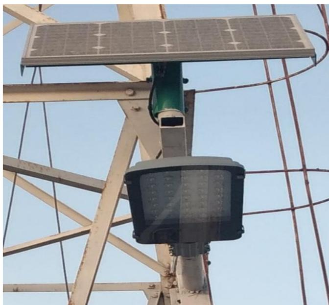
Рисунок 3 – Солнечная панель мощностью 40 Вт с светодиодным светильником
